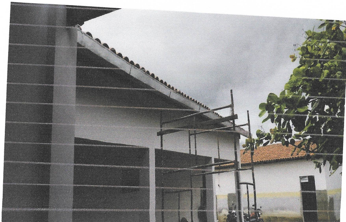
FOTO 04 INSTALAÇÃO DE BICA
