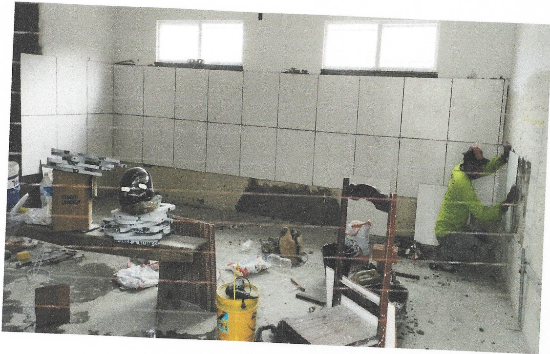
FOTO 09 EXECUÇÃO DE CERAMICA
