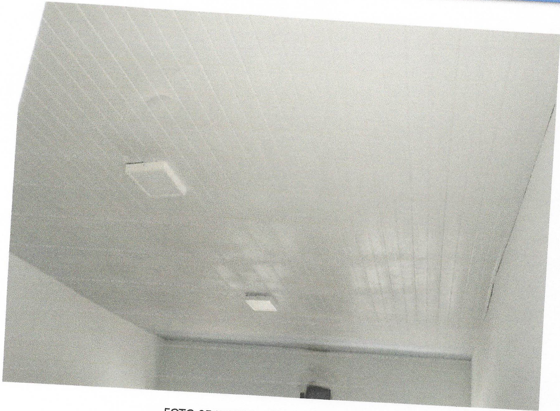
FOTO 05 INSTALAÇÃO DE FORRO PVC
