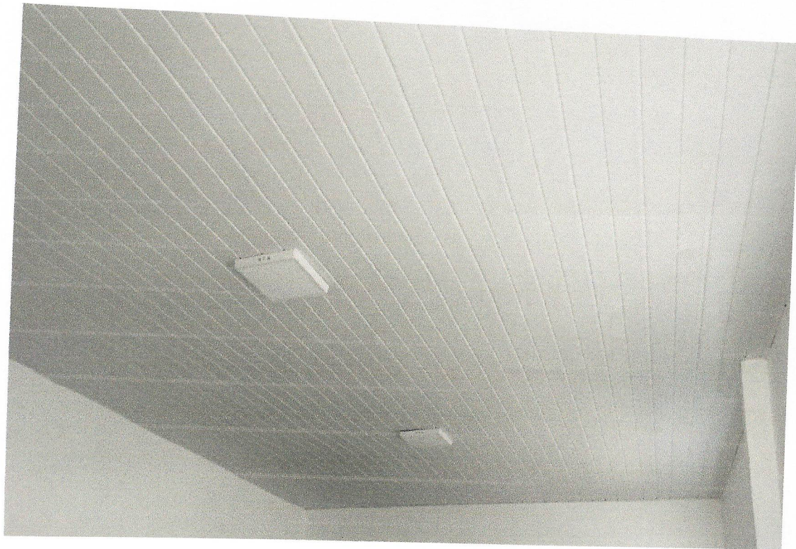
FOTO 06 INSTALAÇÃO DE FORRO PVC
