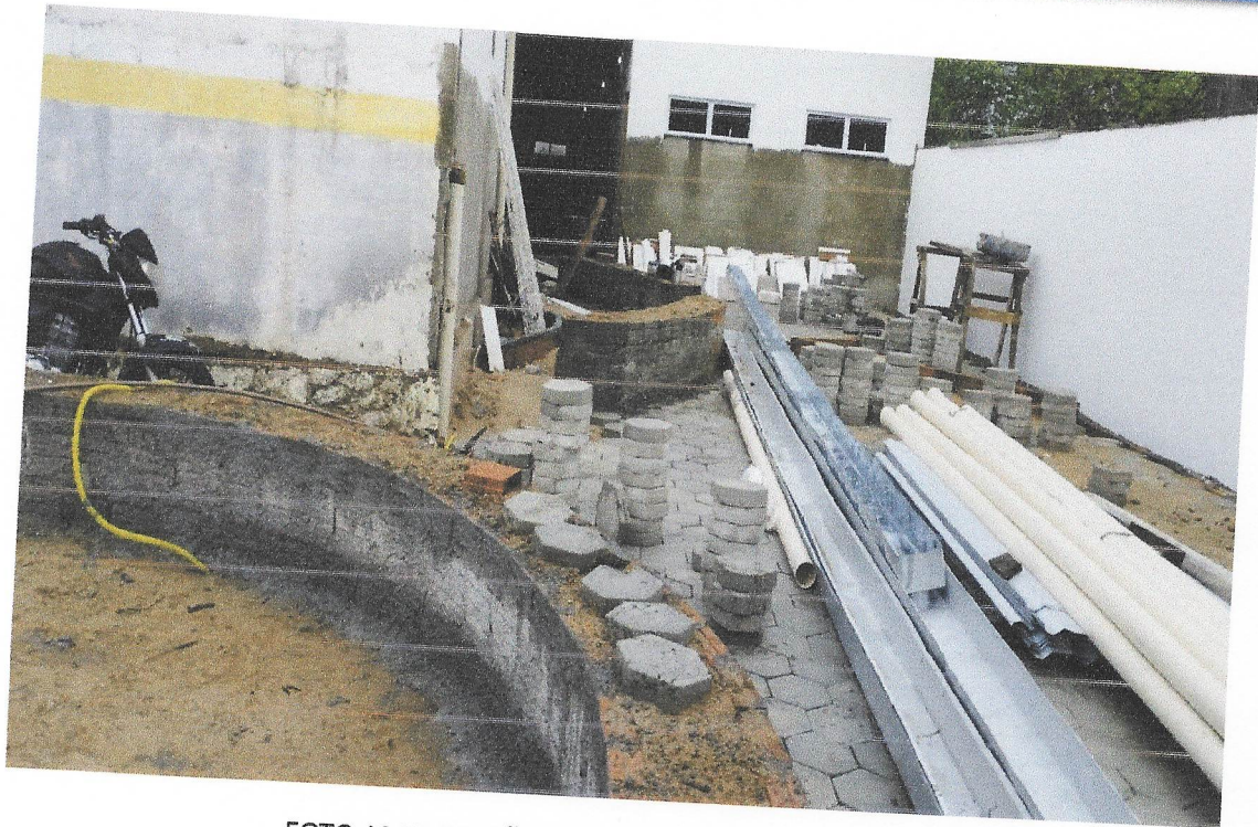
FOTO 13 EXECUÇÃO DE CHAPISCO NOS CANTEIROS
