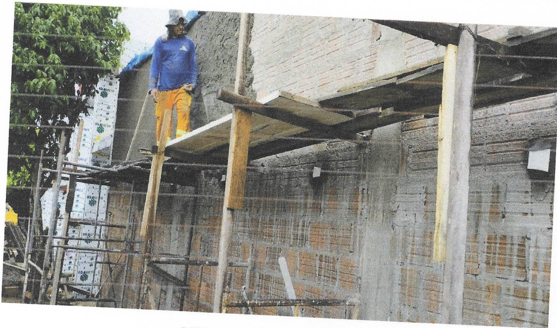
FOTO 07 EXECUÇÃO DE REBOCO
