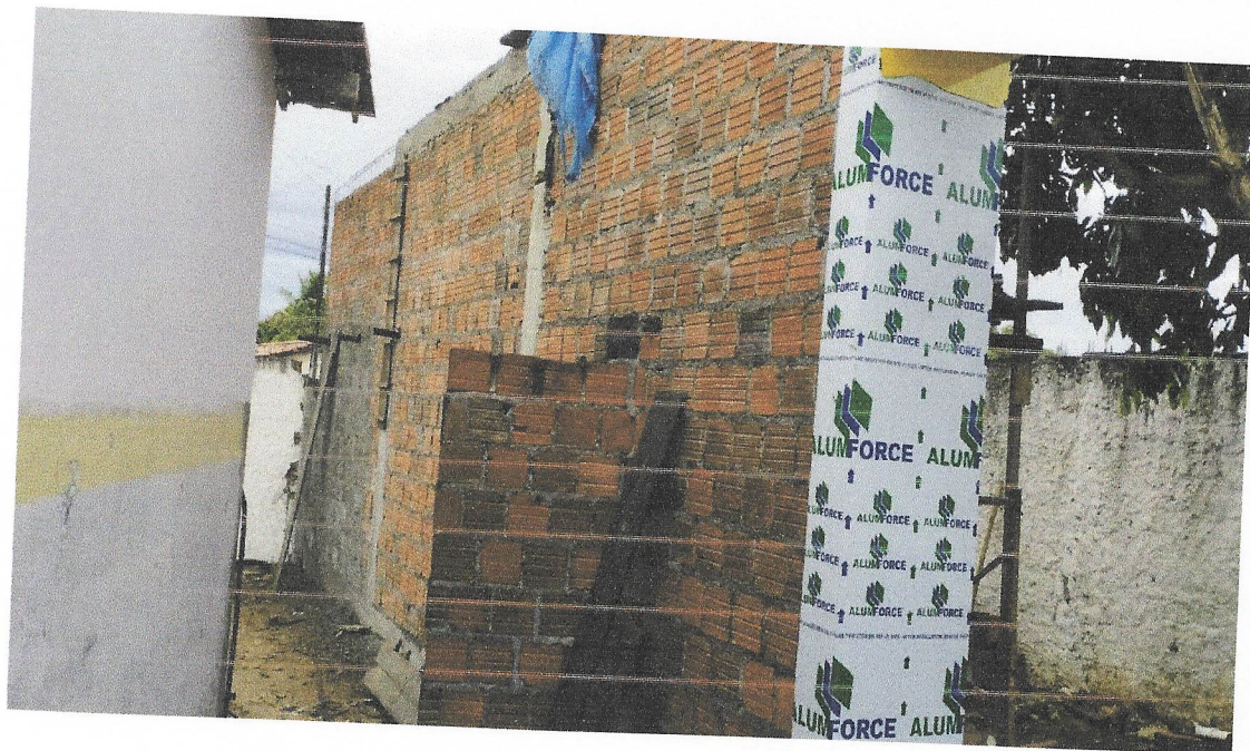
FOTO 08 EXECUÇÃO DE ALVENARIA
