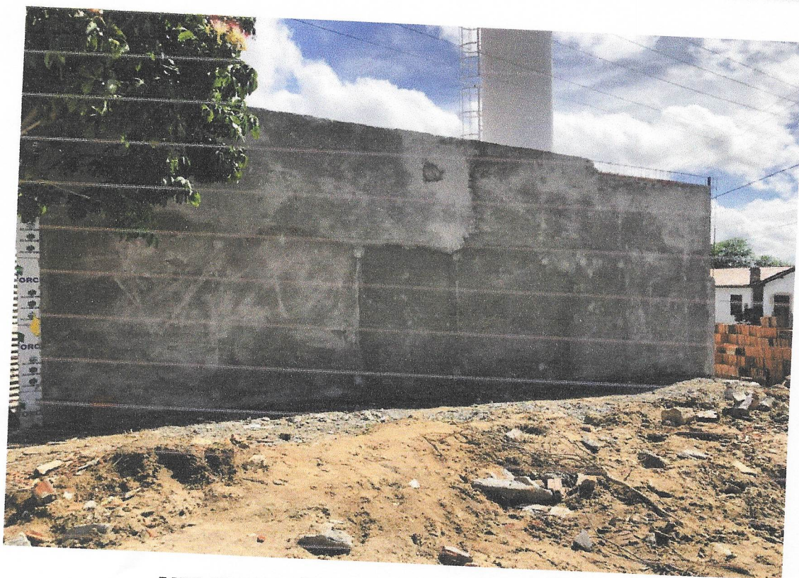
FOTO 17 EXECUÇÃO DE REBOCO DO MURO DA FACHADA
