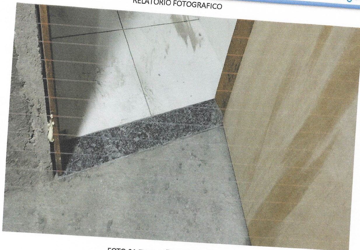
FOTO 01 EXECUÇÃO DE SOLEIRA
