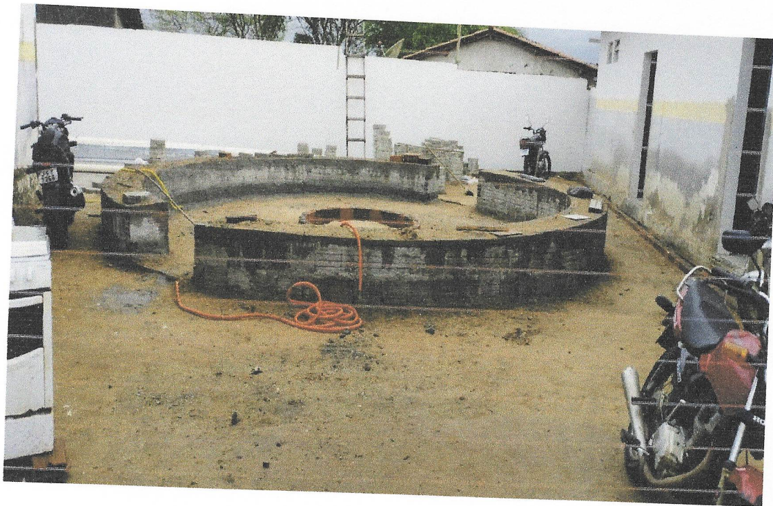
FOTO 14 EXECUÇÃO DE CHAPISCO NOS CANTEIROS
