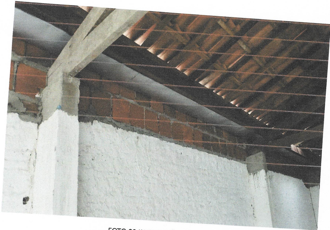
FOTO 03 INSTALAÇÃO DE BICA
