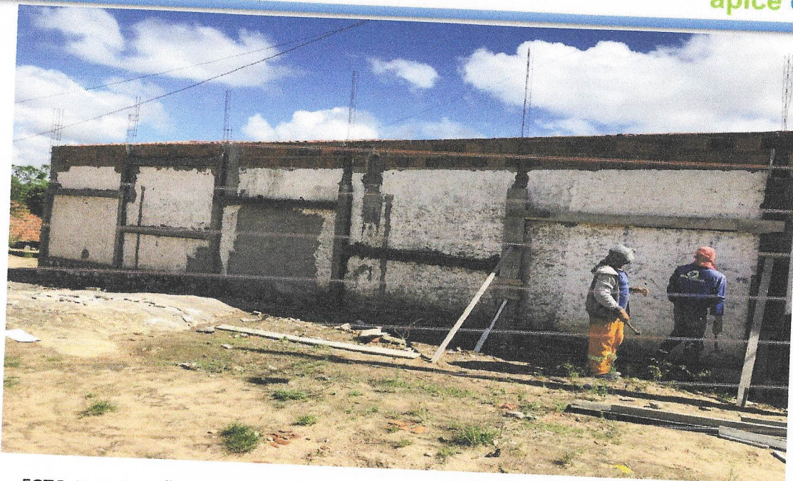
FOTO 15 EXECUÇÃO DE ESTRUTURA PARA FIXAÇÃO DAS TELHAS METALICAS DA FACHADA
