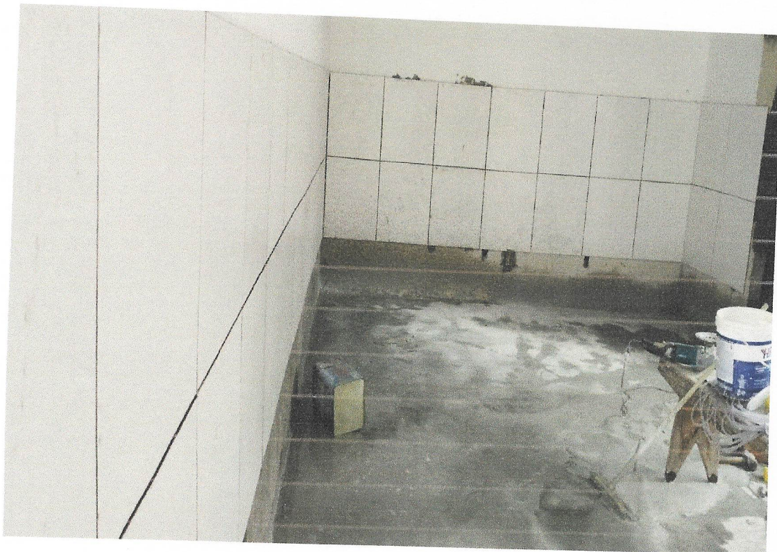
FOTO 10 EXECUÇÃO DE CERAMICA
